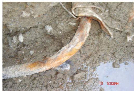
图4 泽园7F腐蚀段开挖结果
