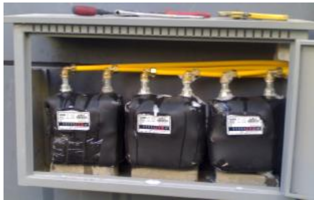
图3 仪表外敷隔热材料示意图
