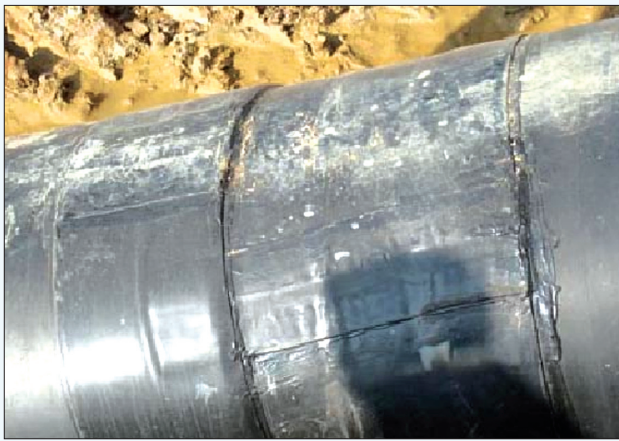
图1 热收缩套补口凸台
