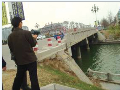
图3 检测板桥的过河管道
