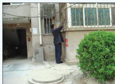
图8 手持检漏仪检测居民户的厨房
