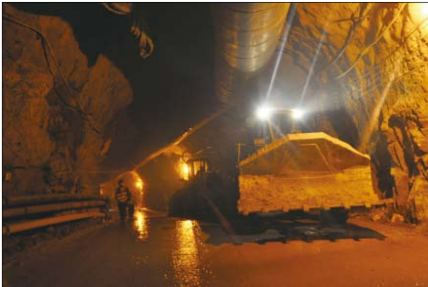
地下储库开挖工作施工人员正在加紧施工
