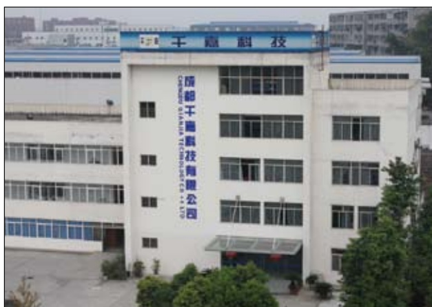
成都千嘉科技有限公司办公楼外观
