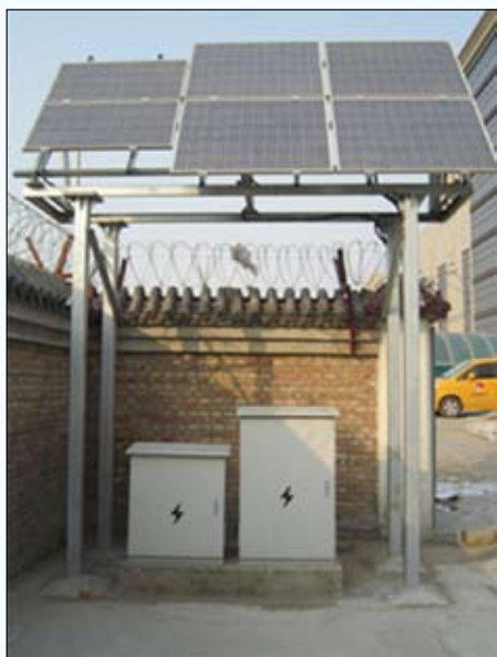
图3 光伏发电系统
