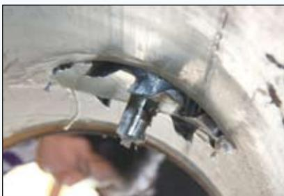
图3 翻转内衬修复后管道开孔
