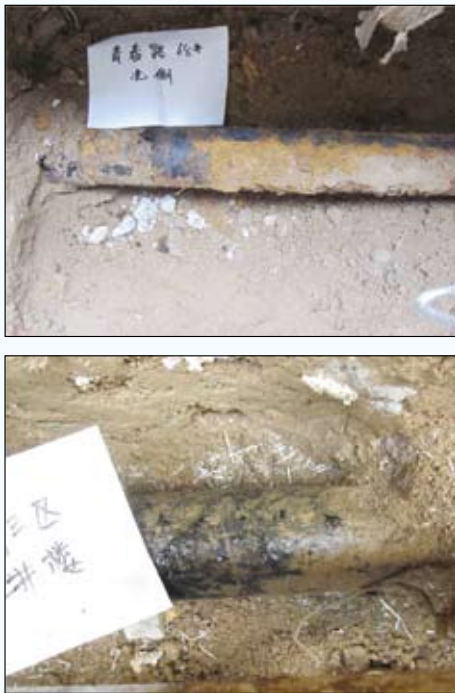
图3 PCM检测出的连续两处破损点位置的开挖检测情况
