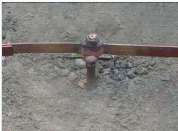
图4 铜包钢接地极
