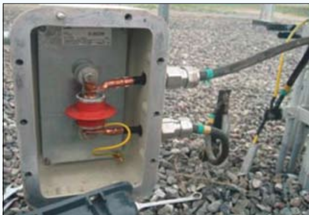
图3 交流驱动的电动阀门连线情况
