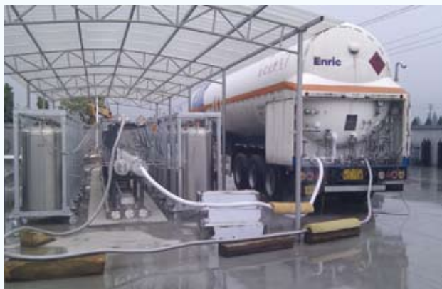
图6 槽车、杜瓦瓶联合运行气化站实景图
