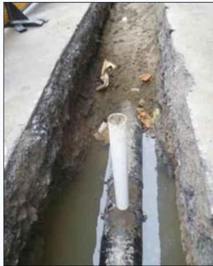
图3 安装完毕后的沉降标
