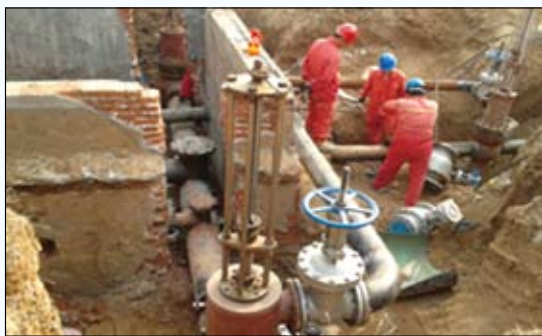
图7 封堵施工现场
