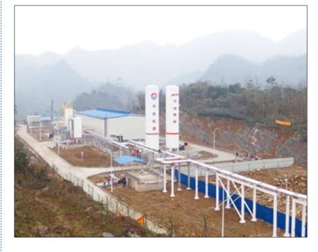
2014年12月31日,中国首座页 岩气液化工厂正式进入运营阶段, 它的成功运营标志着中国页岩气商 业化进入新的发展阶段。该液化工 厂的处理能力为7万m³/d。
