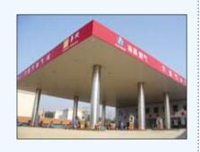
站房采用混凝土框架式结构设 计, 抗爆、防震性能较高。
