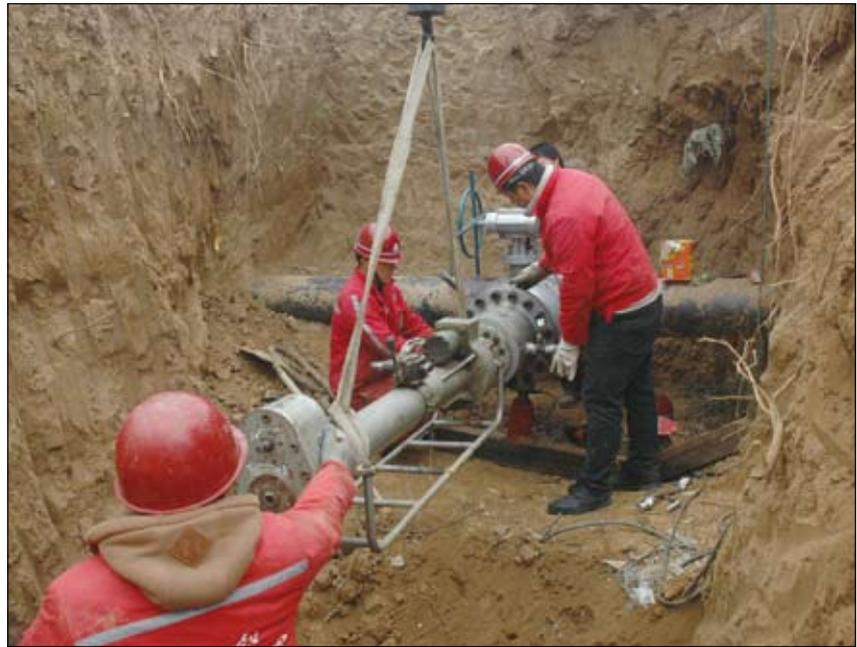
2月6日下午，该公司对东二环次高压天然气管道顺利实施了置换。本次置换采取“氮气隔离”的方式实施，至17:00，随着工作人员将两端阀门开启，济源市城区外围四条道路次高压管网的所有节点已被打通，次高压燃气主管网开始呈环状结构运行。
