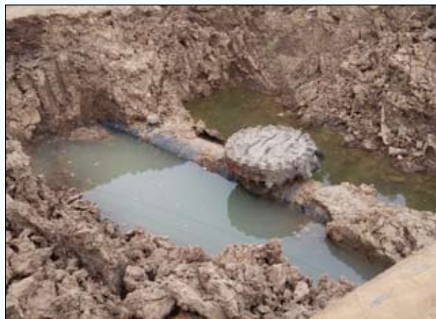
图2 燃气管道泄漏抢修
