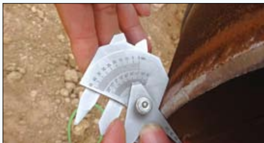
图2 测量坡口尺寸图片
