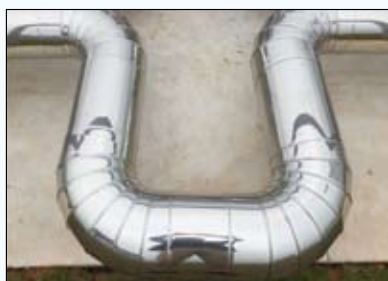
图3 π型补偿器保冷层安装形式
