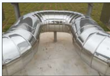
图4 π型补偿器管托的设置
