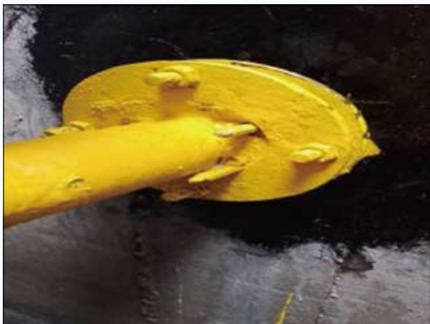
图6 柔性套管内分层压实
