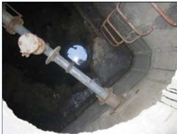
图5 柔性套管未紧固
