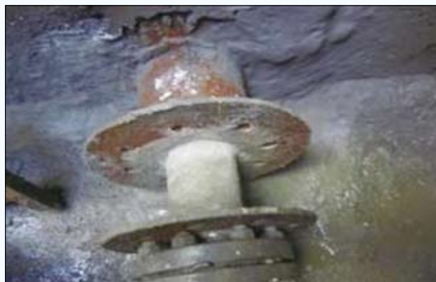
图11 柔性套管修复
