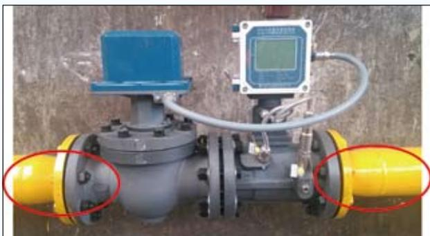
图2 流量计安装及设计不合理
