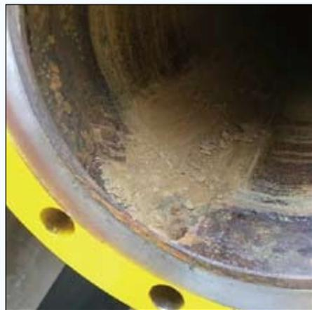
图4 过滤器前端管道内积存泥沙
