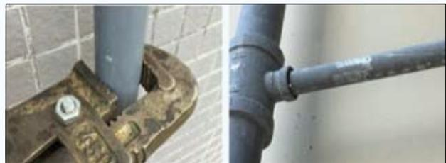
图1 普通金属管钳安装效果图
