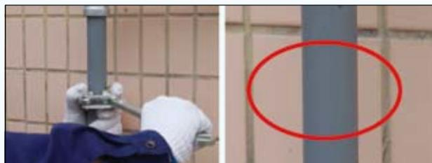
图18 新型无损伤管钳安装效果图
