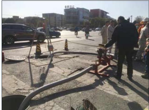
图4 燃气管道放散实验现场图
