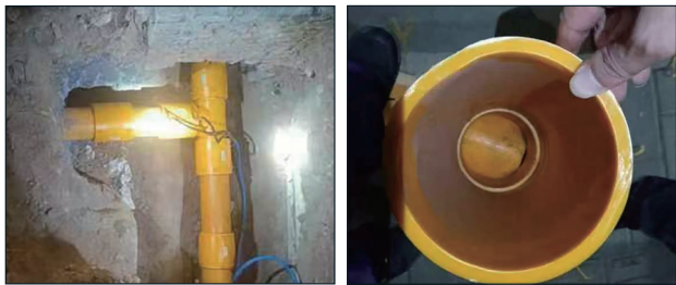
图5 瓶颈点三通位置管道连接实拍图
