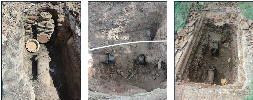
图3 正东路中低压铸铁管网封堵照片
