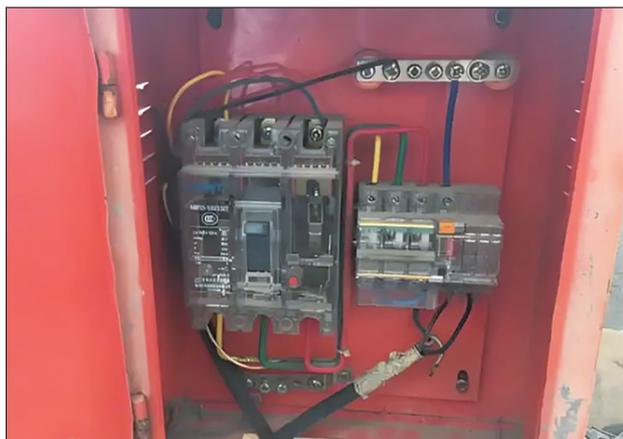
图5 照明开关与动力开关共用一个开关箱
