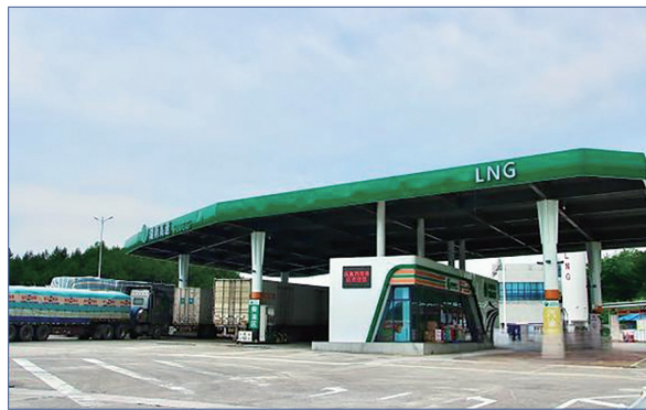
200km建成一对LNG加气站。
