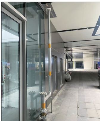
图9 无缝钢管色环实景效果
