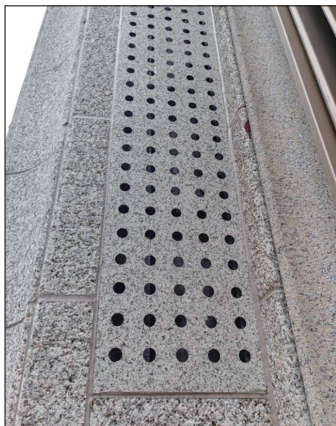
图7 燃气引入管设置于专用U型管槽内
