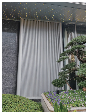
图5 燃气引入管被外立面装饰遮蔽
