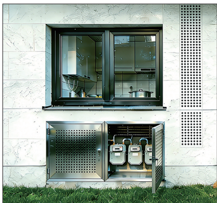
图4 户外集中挂表+表后管（暗封）
