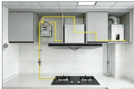
图2 高位橱柜内挂表+表后管暗埋暗封
